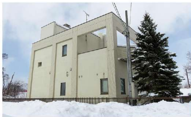
北斗ポンプ場
